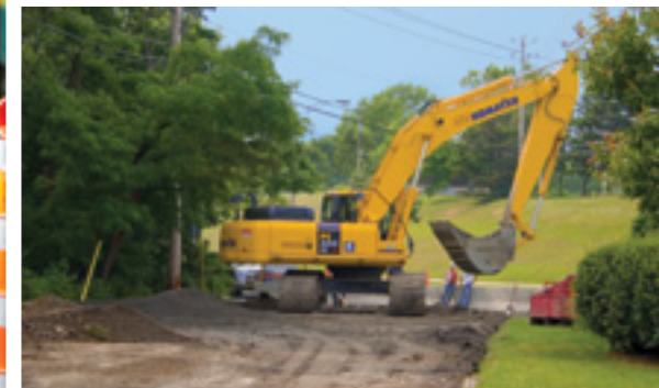
Chantiers en cours
